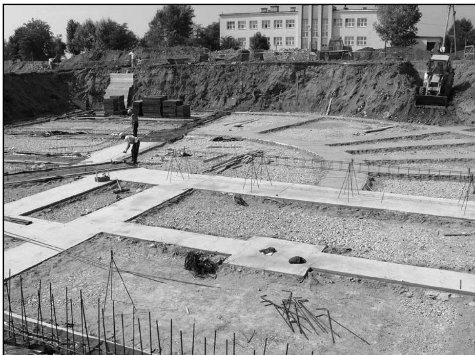
Głęboki wykop powstał w miejscu dawnej kopalni dolomitu
