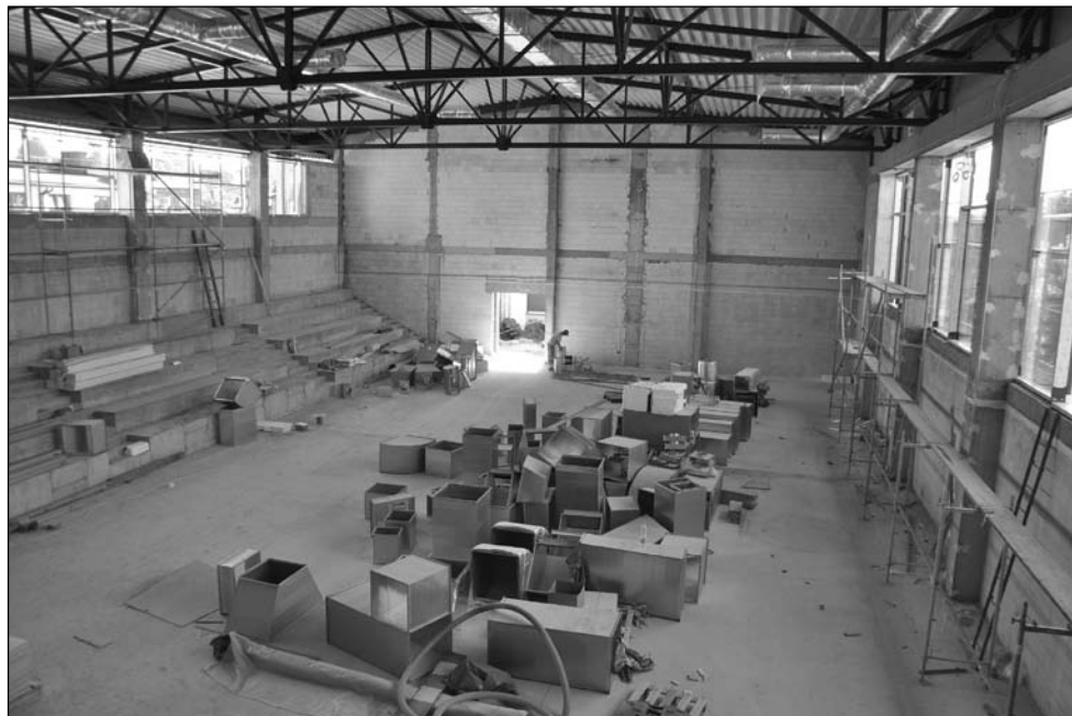
W hali sportowej przy szkole podstawowej na ul. Miarki montowane są okna i instalacje.
