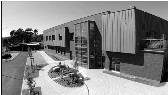
Koszt ponad 134 mln zł wybudowany został nowoczesny zakład segregacji odpadów. Trafia do niego śmieci z 8 gmin (również z Imielina) - członków udziałowców spółki Master. Dzięki temu miasto spełniać będzie również w przyszłości unijne normy dotyczące recyklingu odpadów komunalnych.
