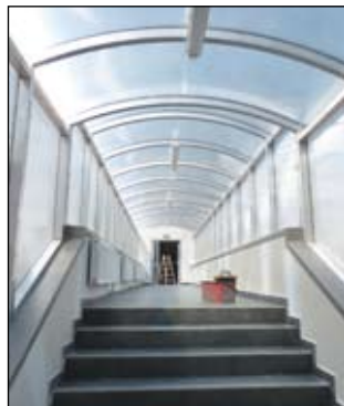
Łącznik między gimnazjum a halą na wysokości pierwszego piętra.
