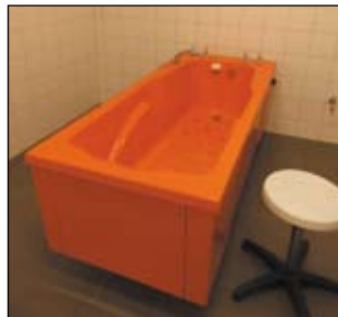
Wanna do hydromsażu w części rehabilitacyjnej hali.
