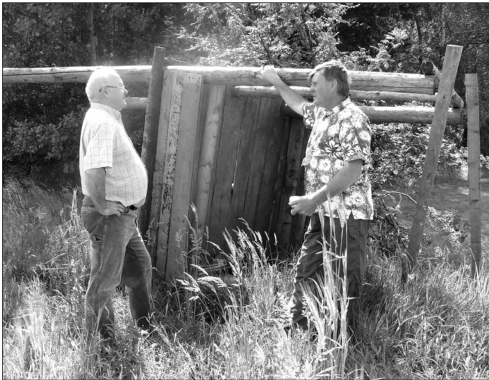
Myśliwi przy zniszczonej ambonie.
