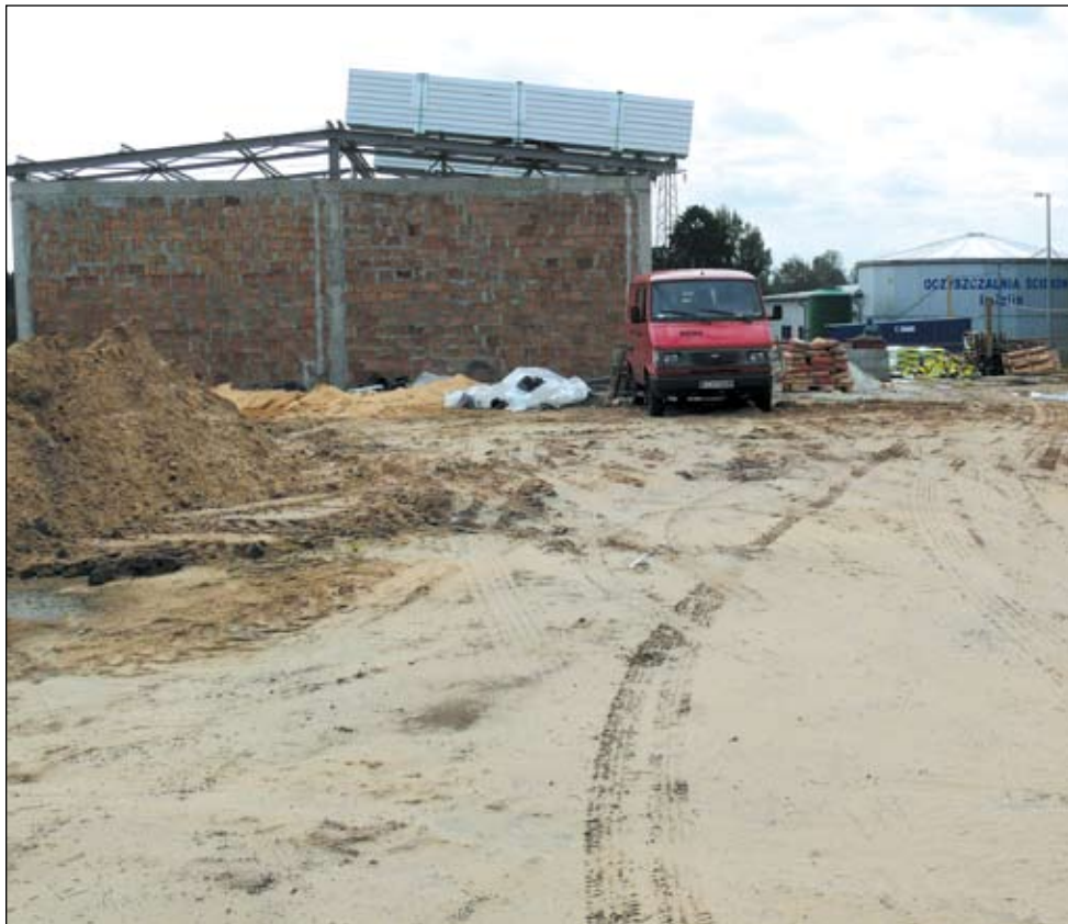
Obok imielińskiej oczyszczalni ścieków przy ul. Wandy powstaje zaplecze socjalno-remontowe dla Miejskiej Spółki Komunalnej.
