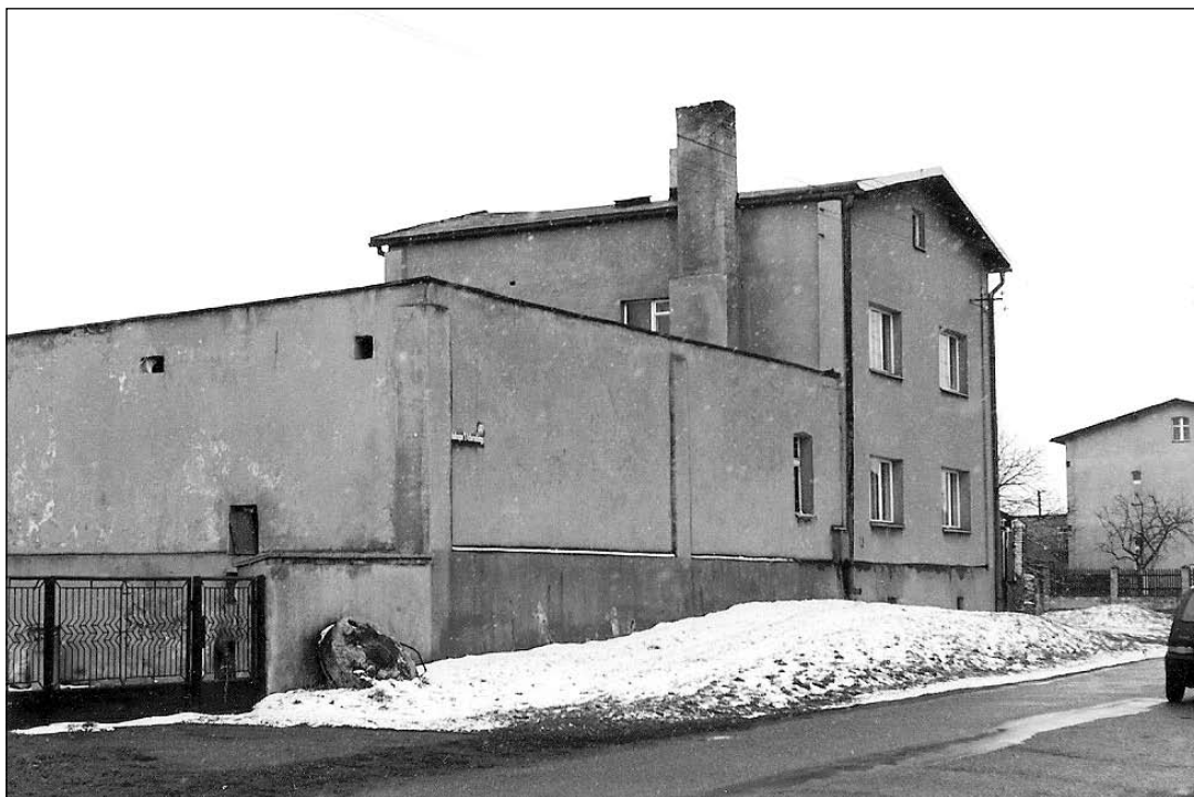
W tym miejscu przy ul. Biskupa Adamskiego stał kiedyś młyn.
