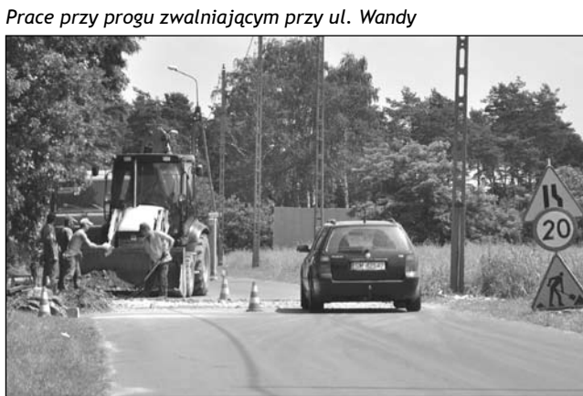
Prace przy progu zwalniającym przy ul. Wandy
