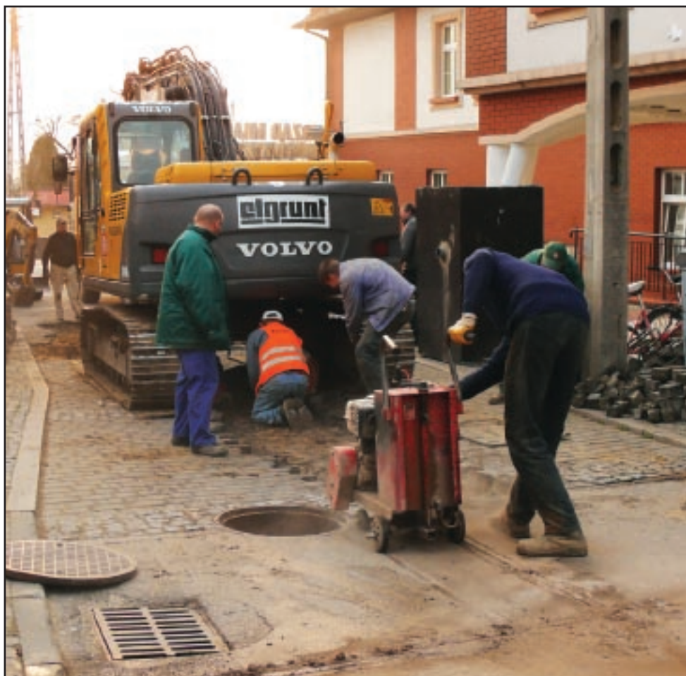
Pierwszy etap budowy kanalizacji obejmuje centrum Imielina.
