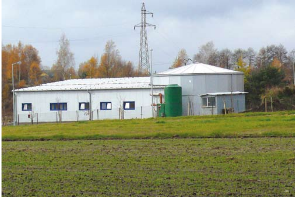
Miejska oczyszczalnia powstała przy ul. Wandy, a przepompownia przy ul. Imielińskiej.
