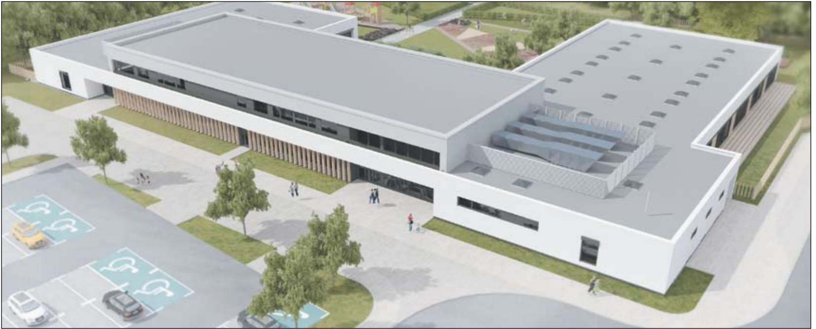
Nowe przedszkole (prawa część budynku) i żłobek (po lewej stronie) - widok od strony ul. Brata Alberta.
